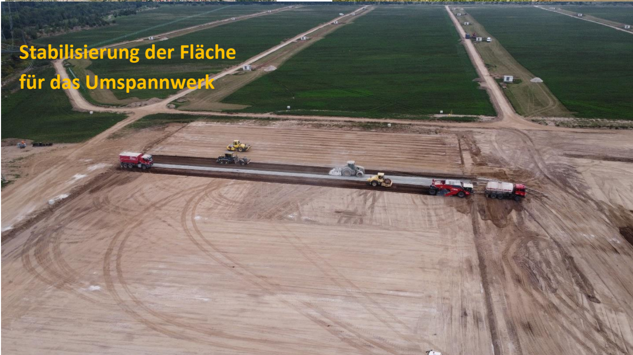
Stabilisierung der Lagerplatz fläche
